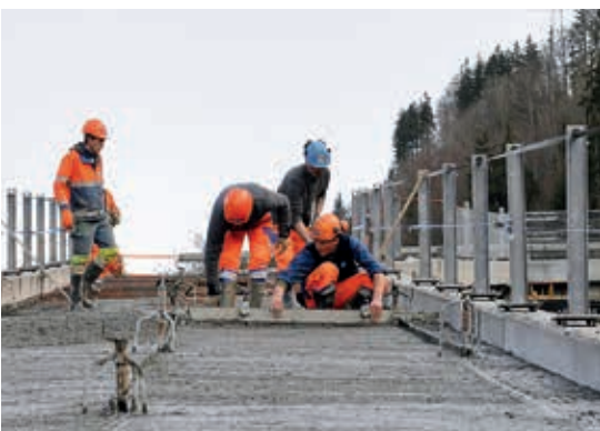
Betonarbeiten an der Rampe der Hilfsbrücke Gloten.
