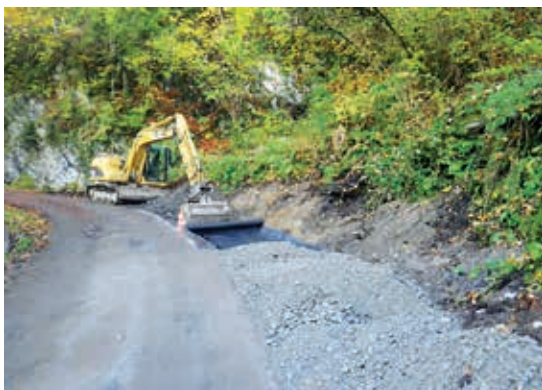
Bau einer Ausweichstelle an der Bauzustellenzufahrt im Gebiet Hohfluh.
