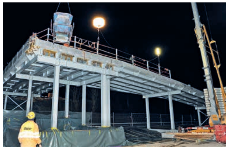
Die Fahrbahn der Hilfsbrücke wurde im Februar in Nachtarbeit betoniert.
