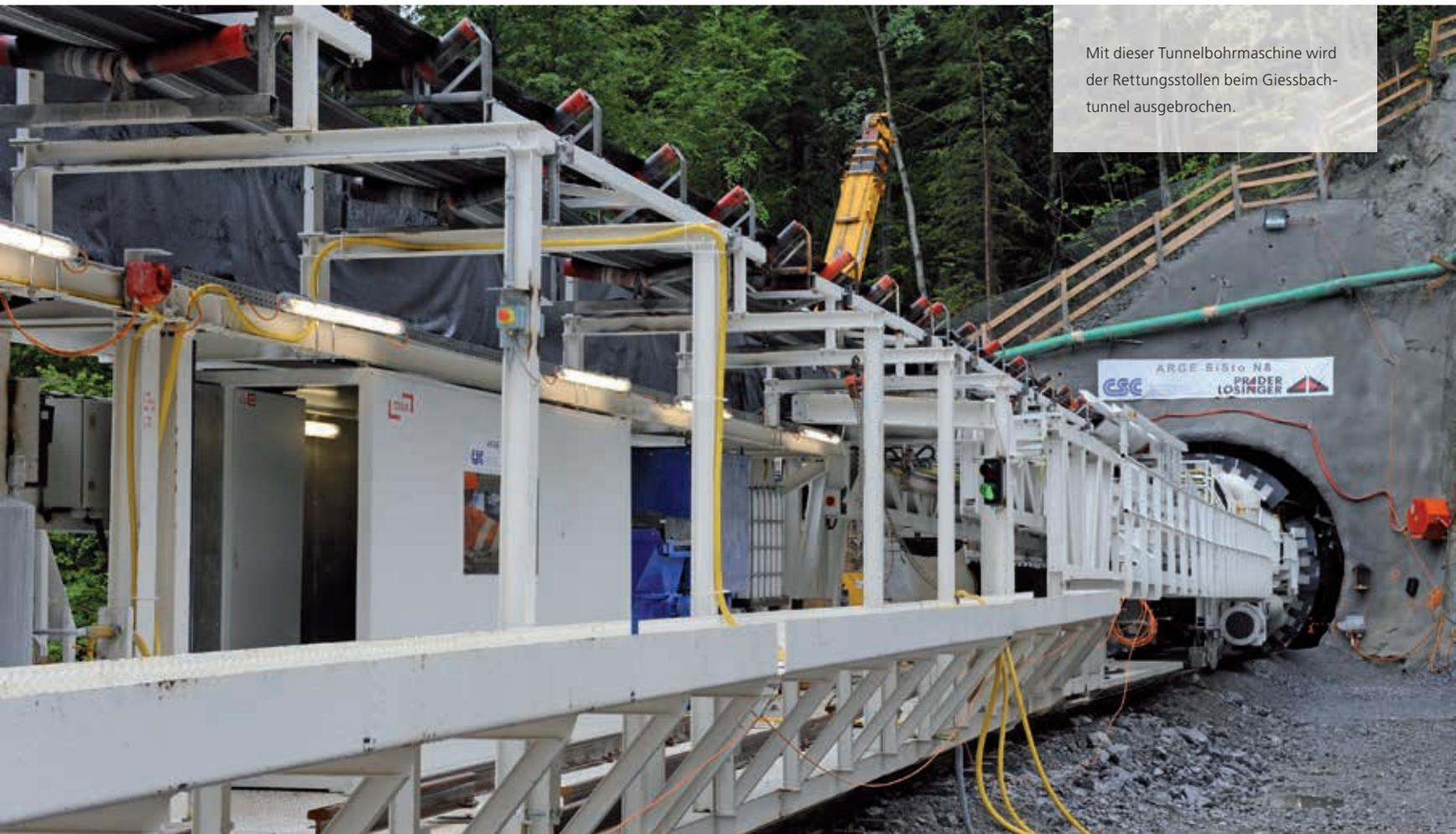
Mit dieser Tunnelbohrmaschine wird der Rettungsstollen beim Giessbachtunnel ausgebrochen.
