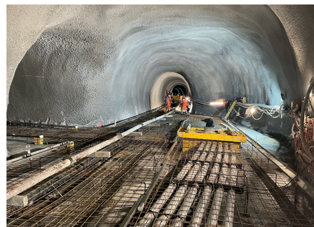
Die Tunnelsohle kurz vor dem Einbringen des Betons. Im Boden verlaufen diverse Rohre und Leitungen.
