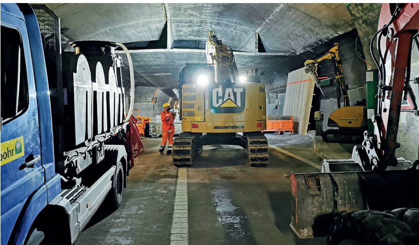
Ein umfangreicher Maschinenpark belegt die Ausstellbucht in der Mitte des Giessbachtunnels.
