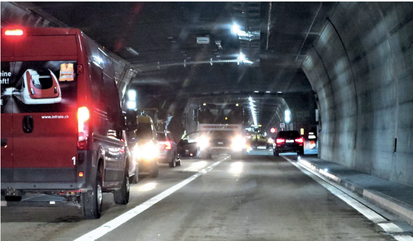
Vor Baubeginn herrscht im Tunnel dichter Baustellenverkehr.
