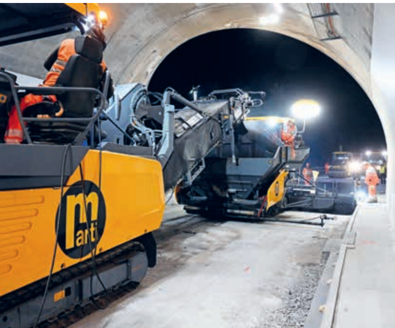
Sobald die alten Betonplatten entfernt sind, wird die Planie aufgetragen.
