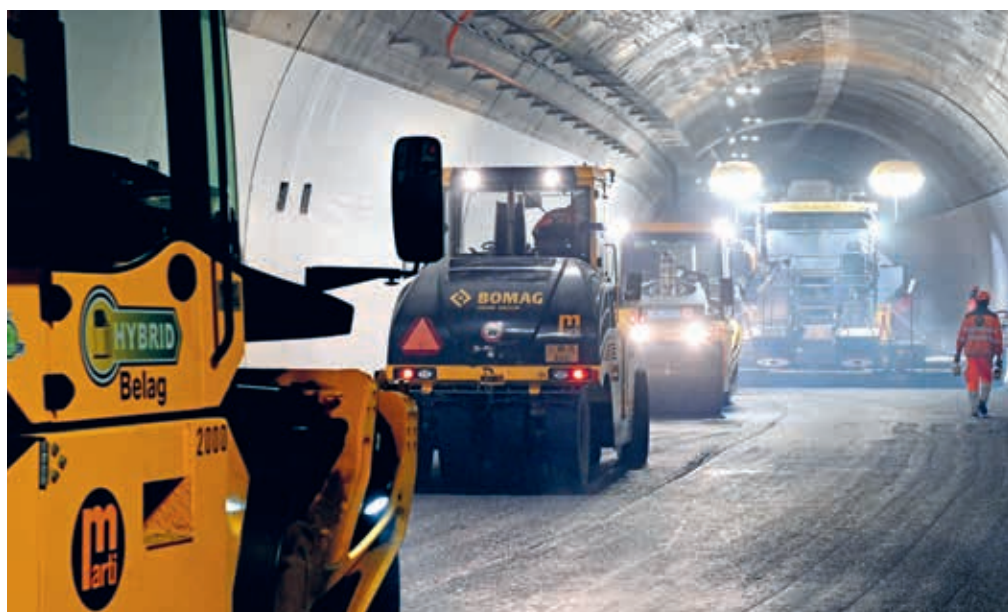
Zuletzt wird die Tragschicht eingebaut.
