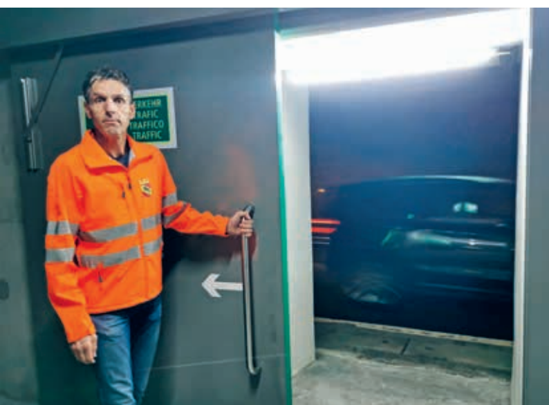
Bruno Kropf bei der Schiebetür zwischen dem Strassentunnel und der Querverbindung zum Sicherheitsstollen.
